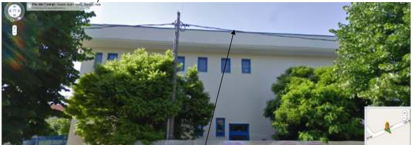
Viste della linea elettrica aerea posta lungo la strada comunale Via Dei Campi (lungo facciata nord dell'edificio oggetto di lavori)
